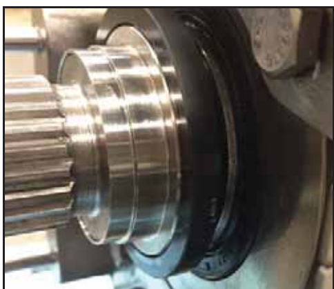
Bild 106 - Roterande tätning installerad
