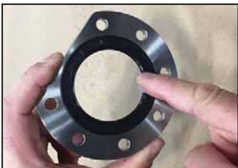
Abbildung 198 - Auftragen von Schmiermittel
