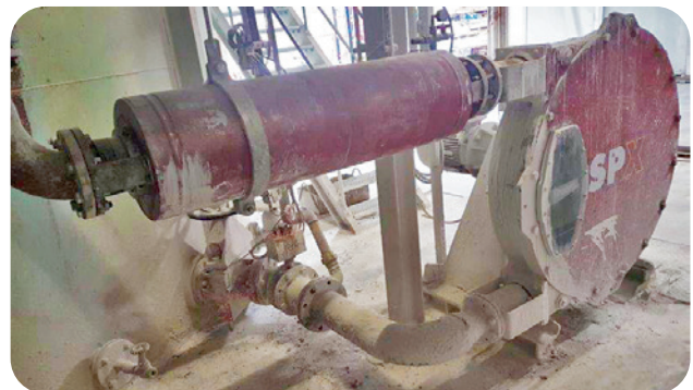
Slangpompen vervangen excentrische verdringer- en centrifugaalpompen voor afvalslurries in productieprocessen van cellenbeton.
