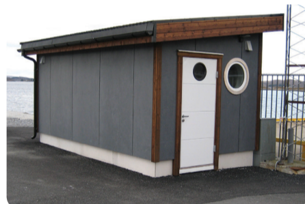
Det skreddersydde vannforsyningsystemet blir styrt fra dette huset ute på kaia i Brønnøy havn. Her får skipene også tilgang til landstrøm, slik at vannforsyningshuset fungerer som en komplett servicestasjon.
