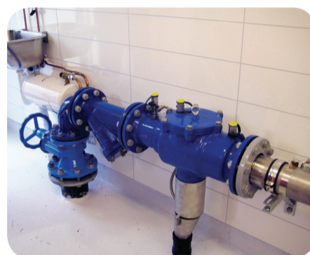
Installasjon av BA300 tilbakeslagssikringsventil kategori 4, FY69P-filtre og sluseventil.
