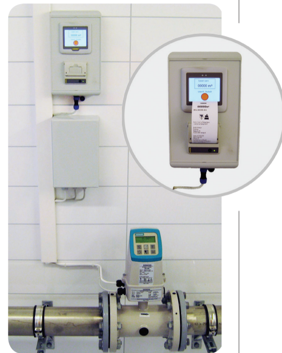
MAG 5100W DN 150 PN 16 elektromagnetisk vannmåler med display. Innfelt: Tilkoblet ferdig konfigurert trykkfølsom skjerm med skriverfunksjon.
