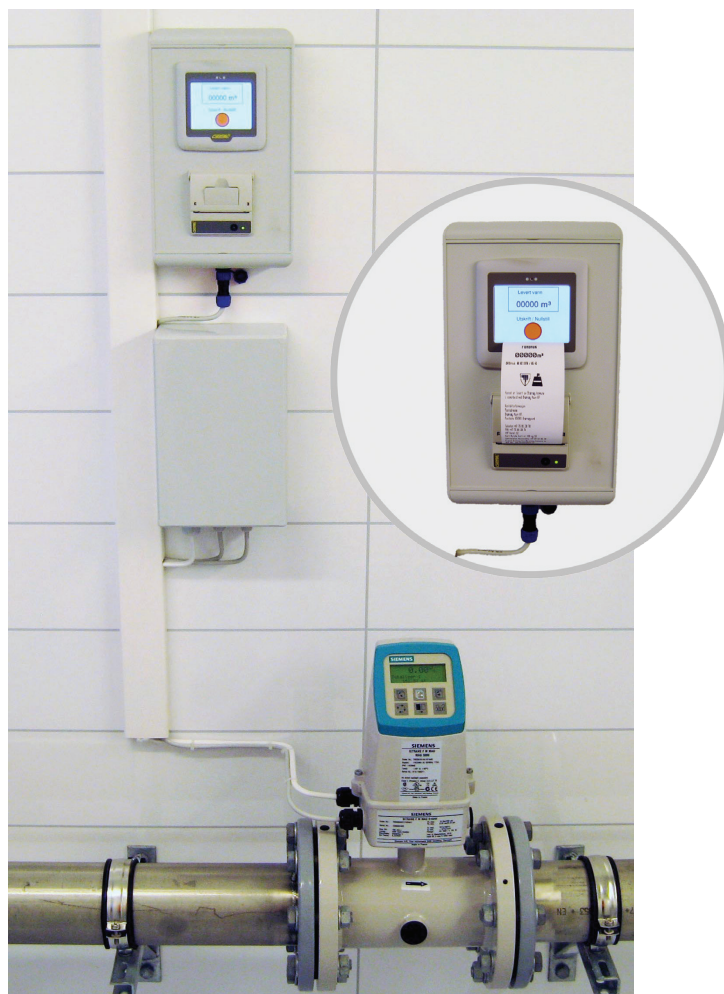
MAG 5100W DN 150 PN 16 ELEKTROMAGNETISK VANNMÅLER MED DISPLAY. INNFELT: TILKOBLET FERDIG KONFIGURERT TRYKKEFØLSOM SKJERM MED SKRIVERFUNKSJON.
