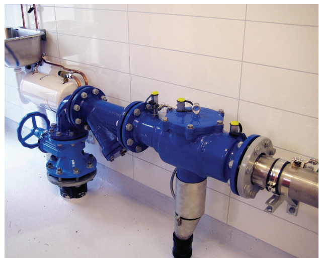
INSTALLASJON AV BA300 TILBAKESLAGSSIKRINGSVENTIL KATEGORI 4, FY69P-FILTER OG SLUSEVENTIL.
