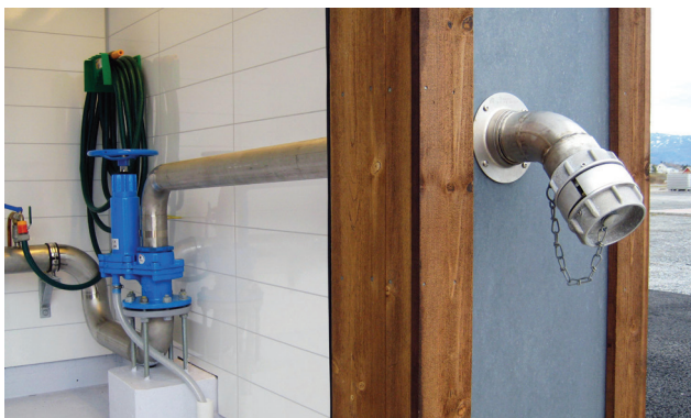
SELVDRENERENDE STENGEVENTIL OG TAPPERØR FOR VANNPRØVER
