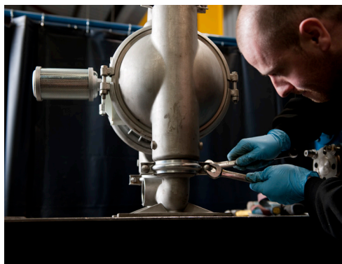
REPARAREA POMPELOR VOLUMICE
