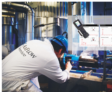
MĂSURAREA VIBRAȚIILOR LA FAȚA LOCULUI
