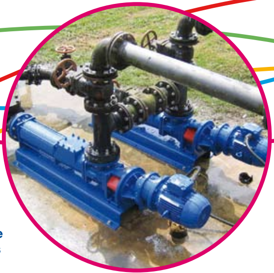
Pompage de boues
