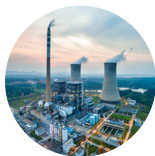
LA LIMPIEZA Y DESULFURIZACIÓN DE GASES DE COMBUSTIÓN
