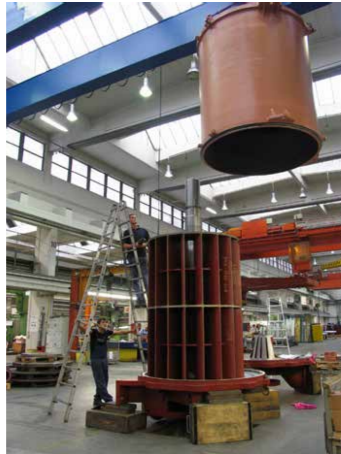
MONTERING AV PUMPHUS
