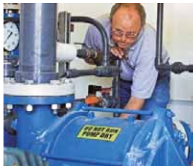
TEST AV VAKUUMPUMPAR
