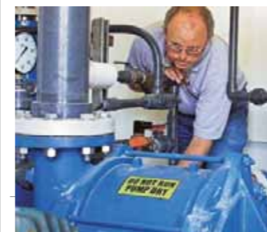
TEST AV VAKUUMPUMPAR
