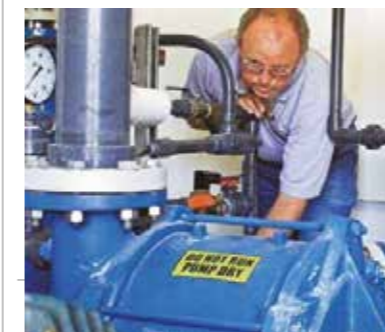
TEST AV VAKUUMPUMPAR
